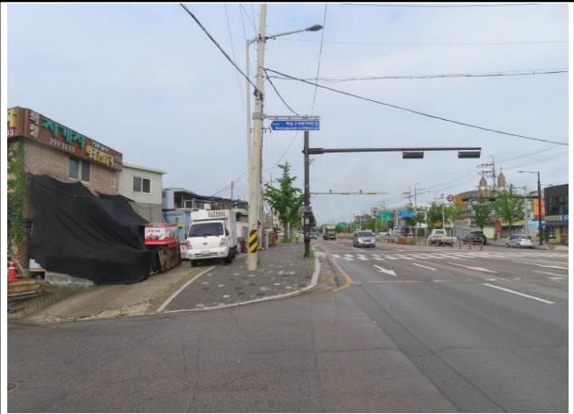
송수-2구간 시점부 전경
