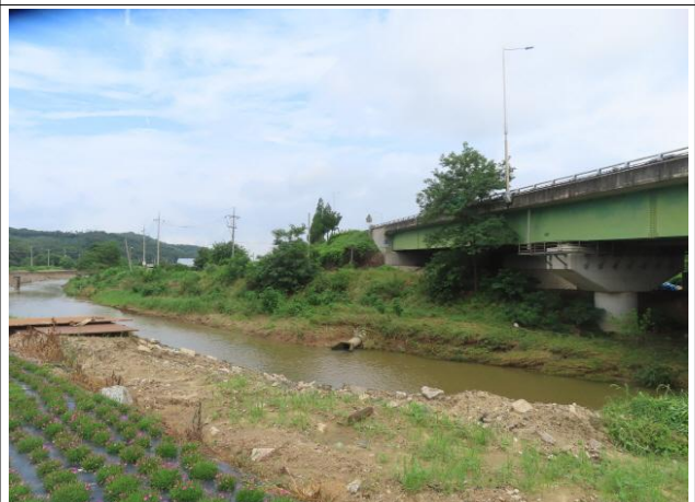
송수-5구간 하천 횡단구간 전경
