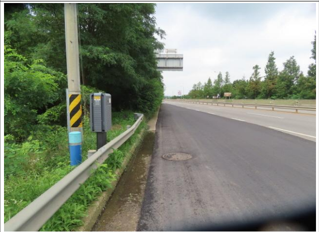
송수-4구간 시점부 전경
