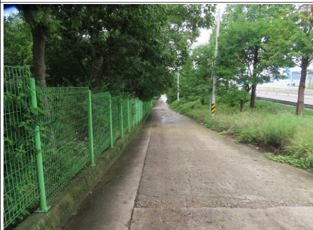
송수-5구간 시점부 전경
