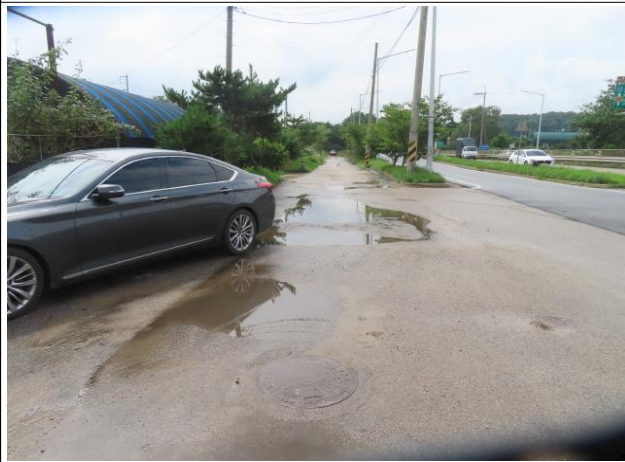
송수-3구간 시점부 전경
